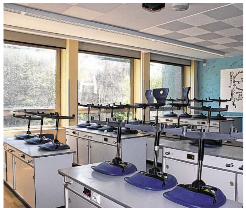
Diese Fenster in einem Naturwissenschaftlichen Raum des Gymnasiums lassen nicht viel „Durchblick“ zu.
