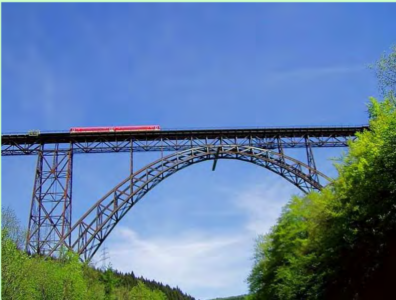
Die Müngstener Brücke wurde beim Brückenfest am 04.05.2003 von Wschrodt fotografiert (Quelle: Wikimedia)
